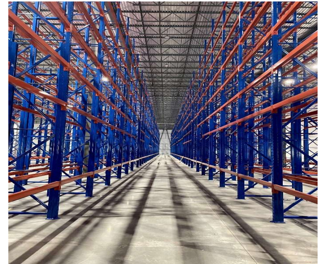
Plafonds de 40 pieds de haut Installation des rayonnages en cours
