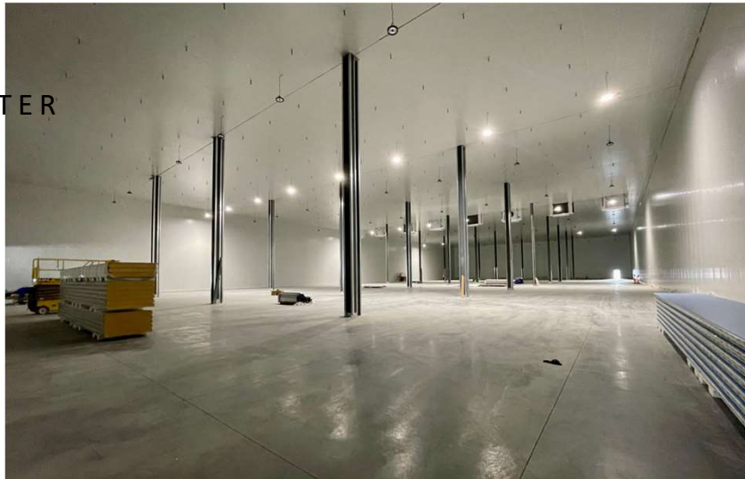
Installation de 321 000 pieds carrés Coulage des planchers terminé plus tôt au 3e trimestre
